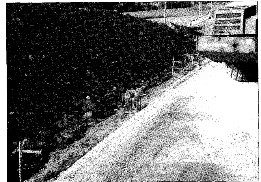
Rys. 3.17. Napinanie linki [11]
