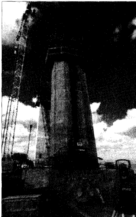
Rys. 4.55. Pomiary kontrolne podpory metodą biegunową
